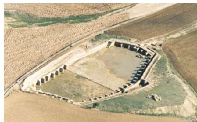
Vista aérea del depósito
