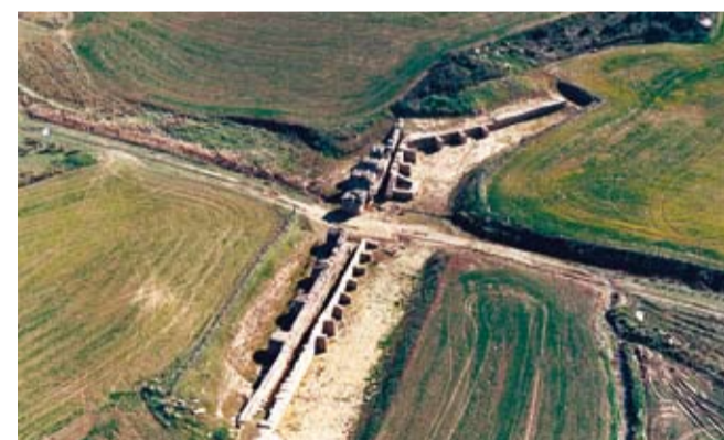
Vista aérea de la presa
